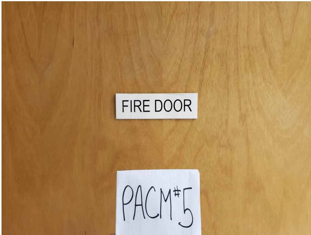
PACM #5 – Fire Door
